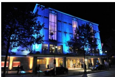
↑夜のオペラハウス外観
